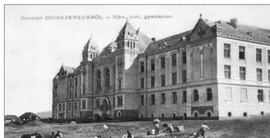
Ismeretlen: A csíkszeredai Római Katolikus Gimnázium építése végén
