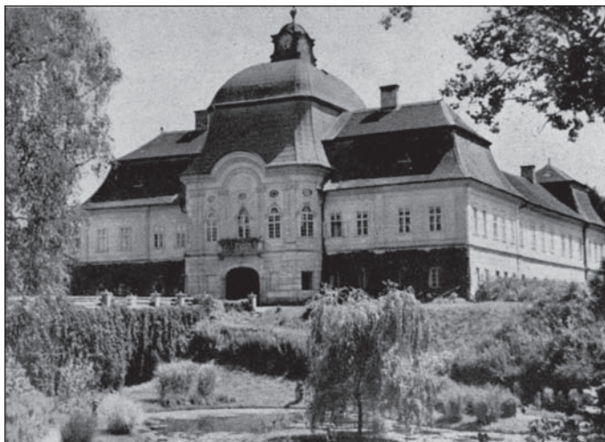
A gernyeszegi Teleki-kastély
